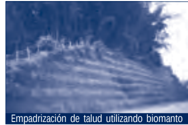
Empradización de talud utilizando biomanto
