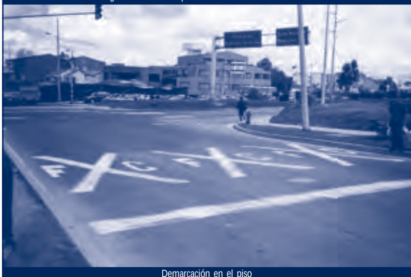
Figura No. 14. Componentes de señalización en Cruce Urbano dentro del Código de Tránsito Colombiano
