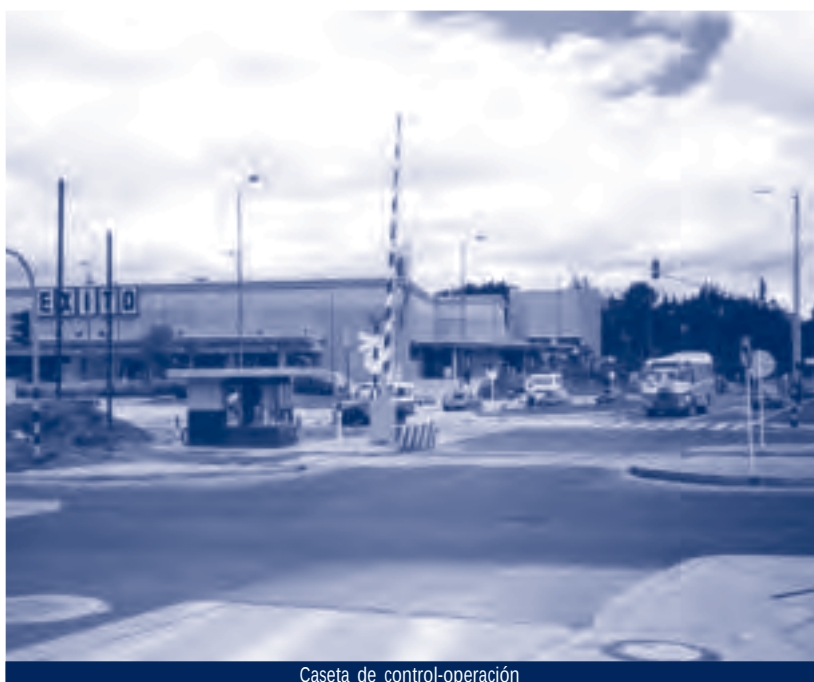
Caseta de control-operación
